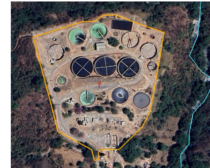
PTAR El Punto
